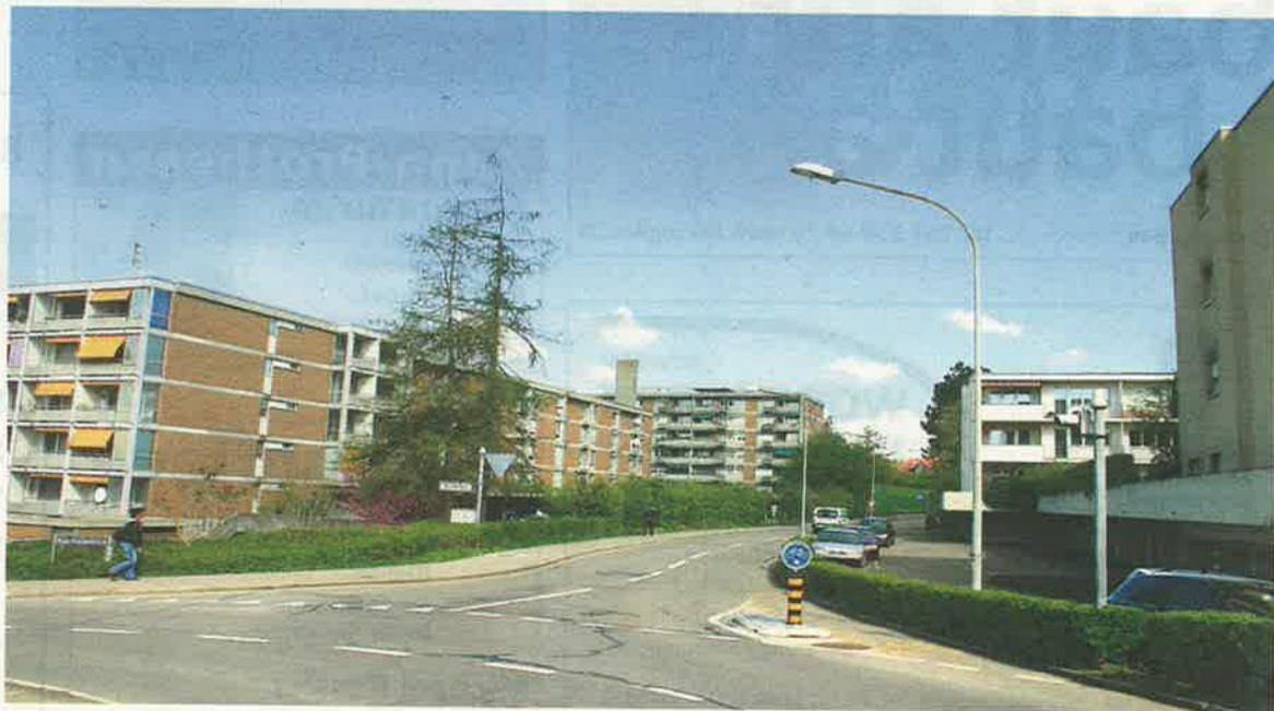
Viele Liegenschaften im Kappelisacker bedürfen einer Sanierung
